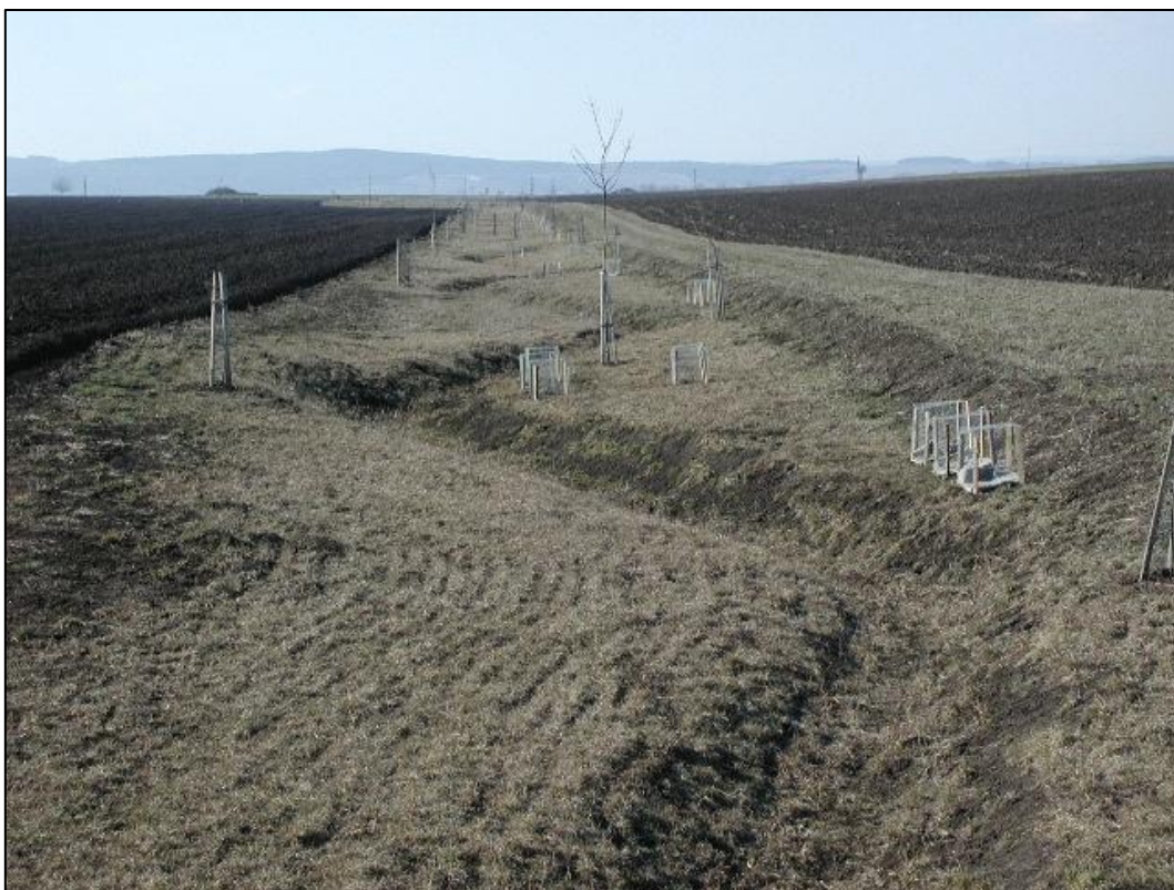
4 Dvojitý lichoběžníkový profil průlehu krátce po dokončení stavby
